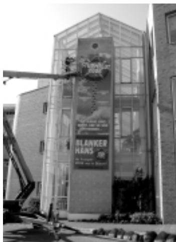
Mit einem Hubsteiger wird das Riesenplakat angebracht
