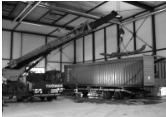
Maßarbeit: In sechs Wochen soll die Bahn eingebaut sein
