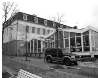
Dieser Anblick ist bald Geschichte: Nach dem Abriß entsteht hier ein Neubau mit Erlebnisgastronomie und Eigentumswohnungen
