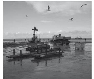
tief im Watt. Drainagerohre und Folien fangen das Nordseewasser auf, dass dann zum Wellenbad gepumpt wird.
