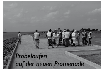
Erste Details des späteren Seebrückenkopfes werden erkennbar
