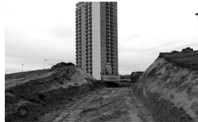
Am Mittwoch um kurz nach 12 Uhr stach die Baggerschaufel das erste mal in die Deichkrone. Wenige Stunden später sah es so aus. Durch diese Durchfahrt gelangen die Baufahrzeuge an den Strand.
