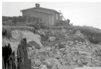
Sturmschaden an der Westseite (1936)
