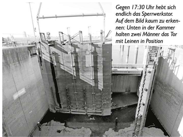
Gegen 17:30 Uhr hebt sich endlich das Sperrwerkstor. Auf dem Bild kaum zu erkennen: Unten in der Kammer halten zwei Männer das Tor mit Leinen in Position
